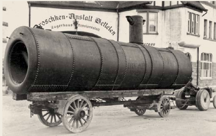
Der Traktor Nr. 1 mit einem Querrohrdampfkessel an der Türkheimerstrasse (um 1927)
