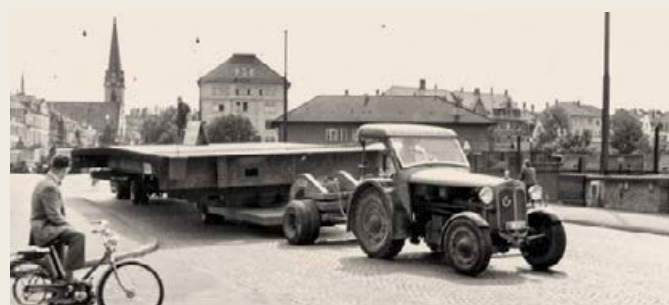
Eine Baustahlplatte für die Fahrbahn der St. Alban-Brücke auf der Münchensteinerbrücke
