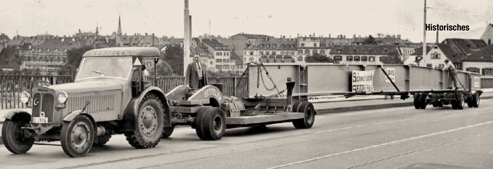
Die Trägerelemente für die St. Alban-Brücke unterwegs (1954)
