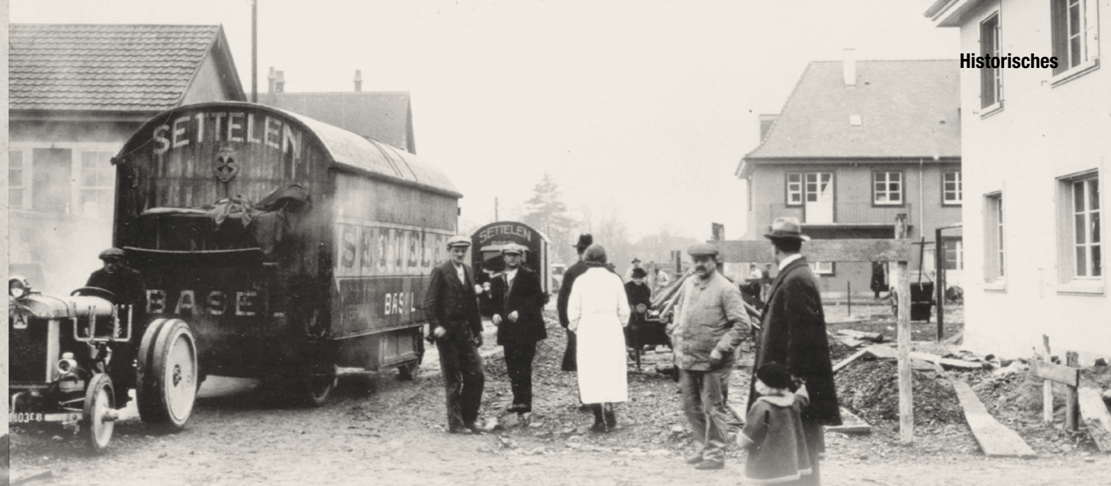
Umzug mit dem brandneuen ersten Fordson-Traktor von Settelen ins entstehende Hirzbrunnenquartier, das ab dem Winter 1924/25 vor allem für kinderreiche Familien erschlossen wird
